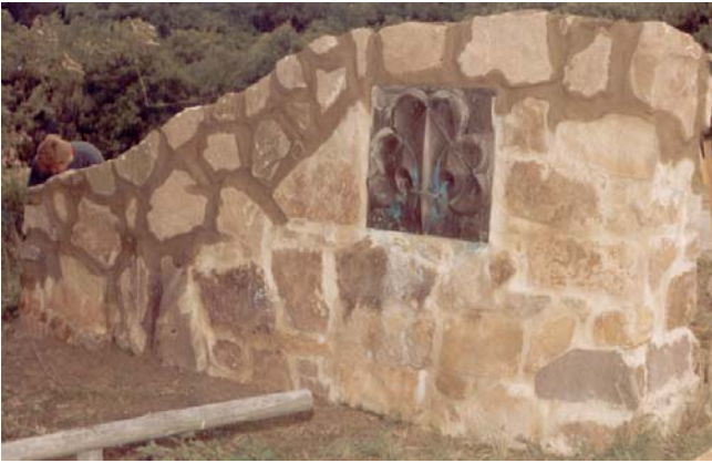
Die Schildmauer mit dem Bundeszeichen ist fertiggestellt.
