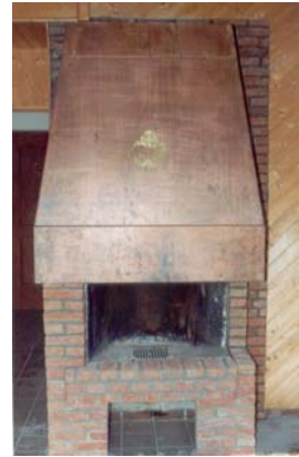
Die neue Kaminabzugshaube
